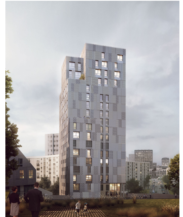
TOUR WATT Réhabilitation, extension et surélévation de la Tour du Loiret ; Paris (75), France ; Livraison 2020 ; ICF Novedis
