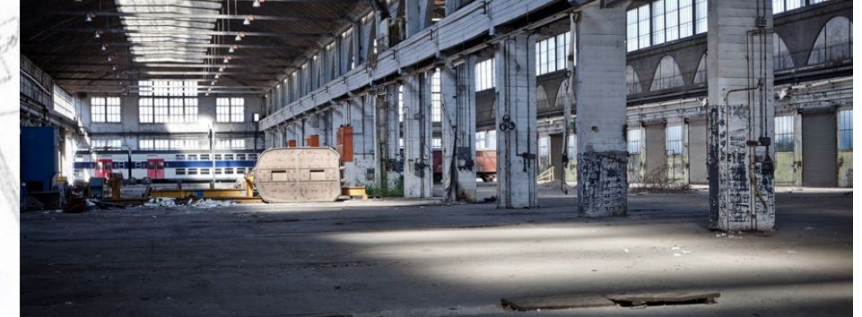
Halles (PCA Stream) – état actuel – des volumes majestueux
